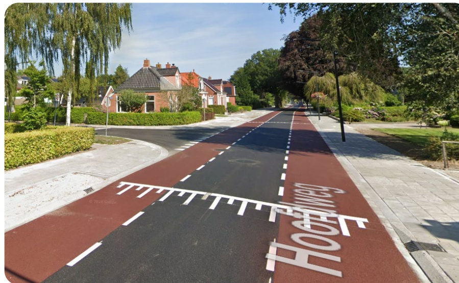
Figuur 12: Voorbeeld van een GOW30 in Paterswolde
